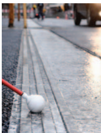
A Monthey, la canne vient buter perpendiculairement à la bande délimitant la zone où peuvent circuler les véhicules.
